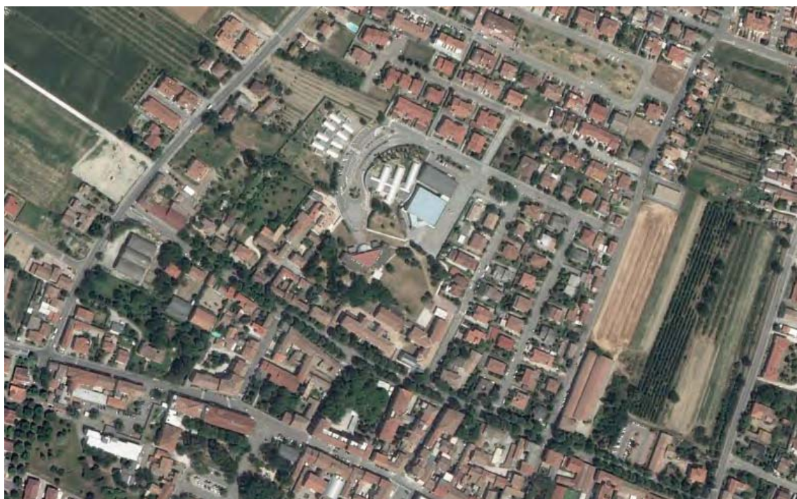
Foto aerea con individuazione dell'ambito di intervento
